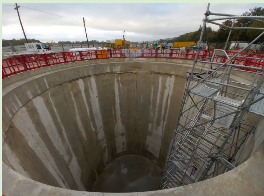
Puits de travail à l'abri des parois moulées (Projet VL8).
