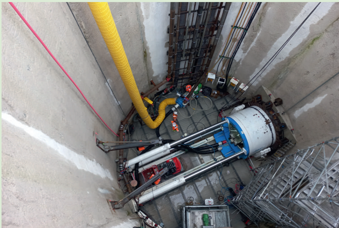
Travaux de réalisation du projet VL8 (Mission G2 Pro Infraneo).
