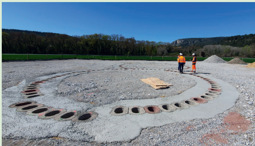
Démarrage des travaux pour la réalisation des puits en pieux sécants dans le lit majeur de la Durance.
